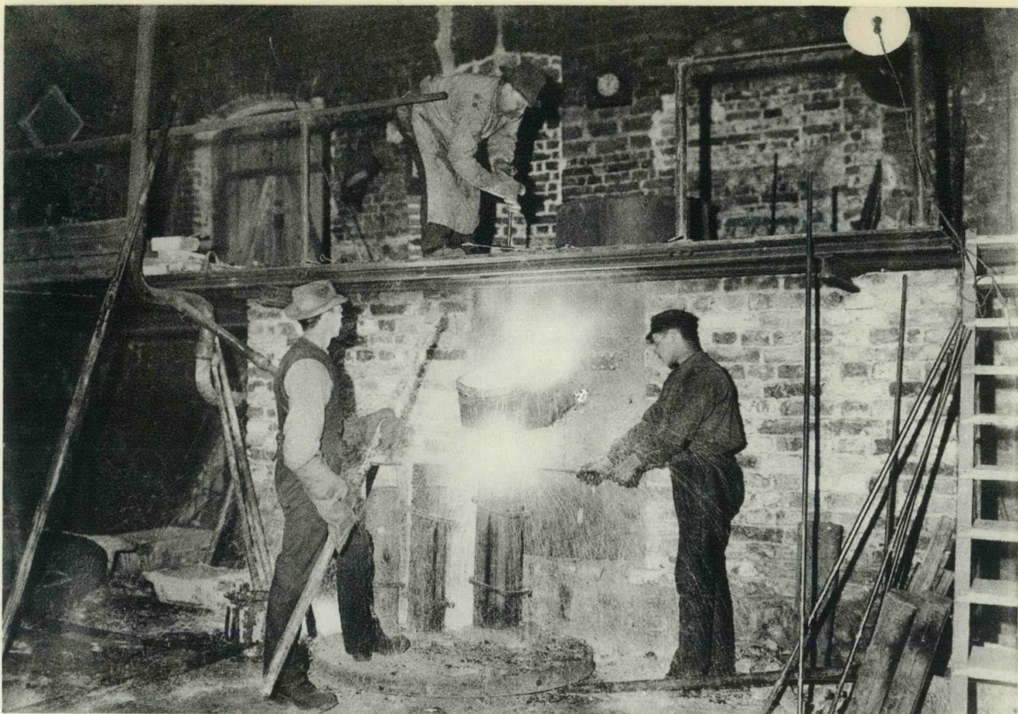
Arbete vid Kjellins elektriska induktionsugn vid Gysinge, Gästrikland. Foto 1902.
