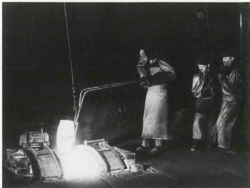
1. Wikmanshyttans degelstålverk var i drift 1859–1944. Här var man 1882 först i Sverige med tillverkning av krom- och volframstål. Stålet var troligen låglegerat och inte rostfritt. Foto STM.
