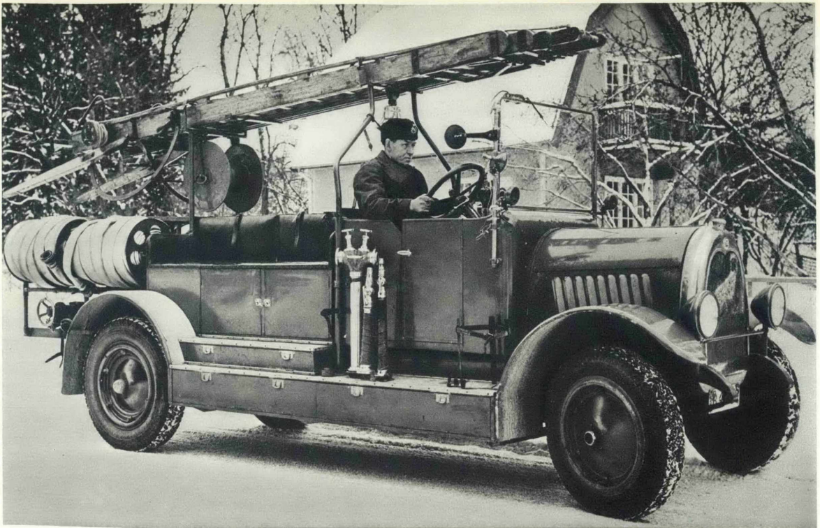
Brandvagn från 1929 med 50 hk motor, byggd i ett block, och en maximal hastighet av 60—70 km/tim.
