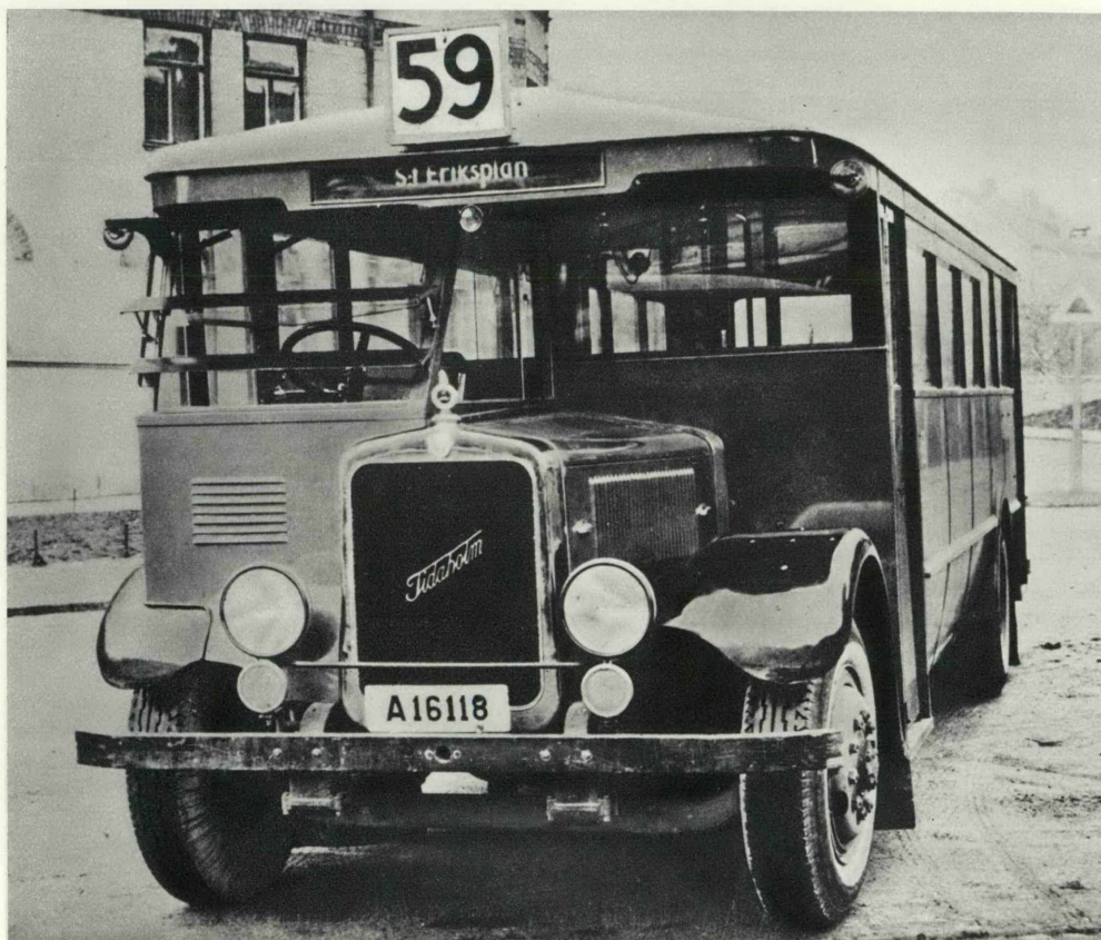
År 1932 inköpte Stockholms Spårvägar bussar med halvt framflyttat förarsäte och hesselmanmotor typ A 52—H på 100 hk.
